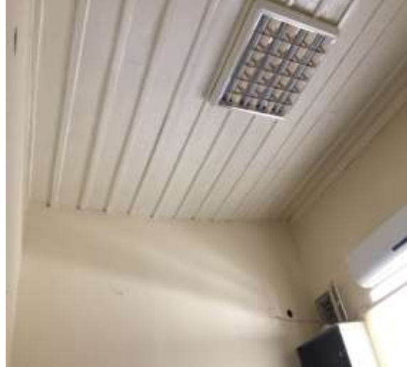
Şekil 5.28. Kapının üstündeki kiriş detayı ve oda tavanlarındaki ahşap lambri (Özmeriyurt, 18.03.2018)
