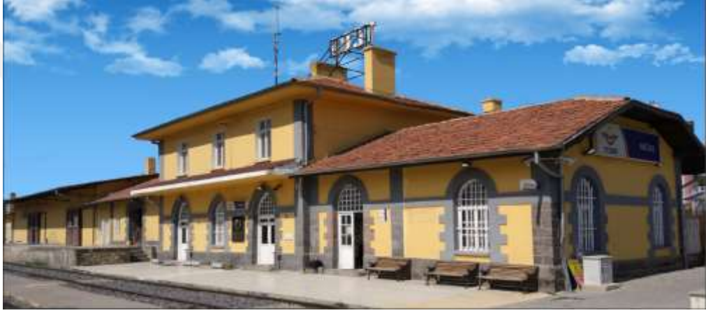
Şekil 5.21. Ana Gar Binası güneydoğu cephesi(Özmertyurt, 20.05.2018)
