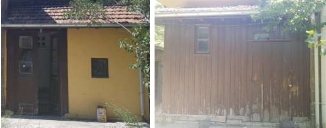
Şekil 5.35. Gar Lojman Binası 1, solda kuzeydoğu ve sağda güneybatı giriş cephesi (Özmertyurt, 18.07.2018).
