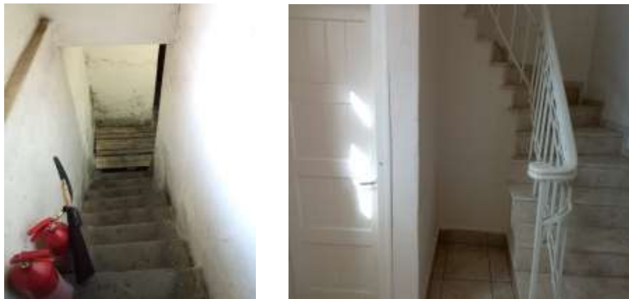
Şekil 5.50. Gar Ek Hizmet Binası 2, merdivenler (Özmertyurt 10.05.2018).
