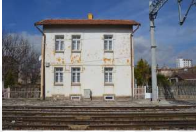
Şekil 5.40. Gar Lojman Binası 2, güneydoğu cephesi (Özmertyurt, 18.07.2018).
