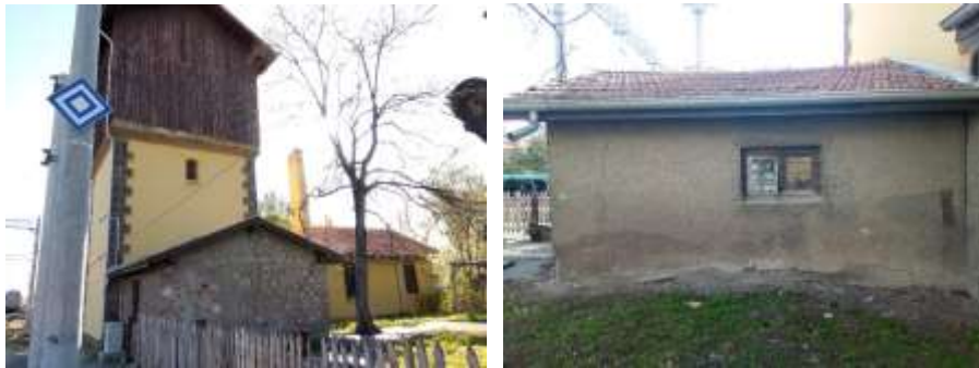
Şekil 5.77. 21 numaralı kömürlük yapısının kuzeydoğu ve kuzeybatı cepheleri (Özmertyurt, 07.04.2018)
