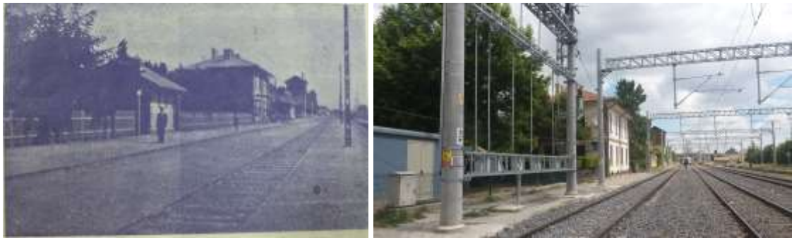
Şekil 5.43. Gar Hizmet Binası 2, 1938'deki durumu (Anonim, 1938) ve günümüz durumu (Özmertyurt 18.07.2018).
