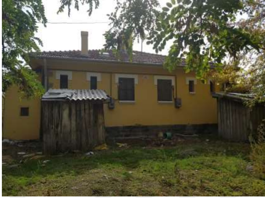
Şekil 5.32. Gar Lojman Binası 1, kuzeybatı cephesindeki ikiz kömürlükler (Özmertyurt, 16.10.2018).
