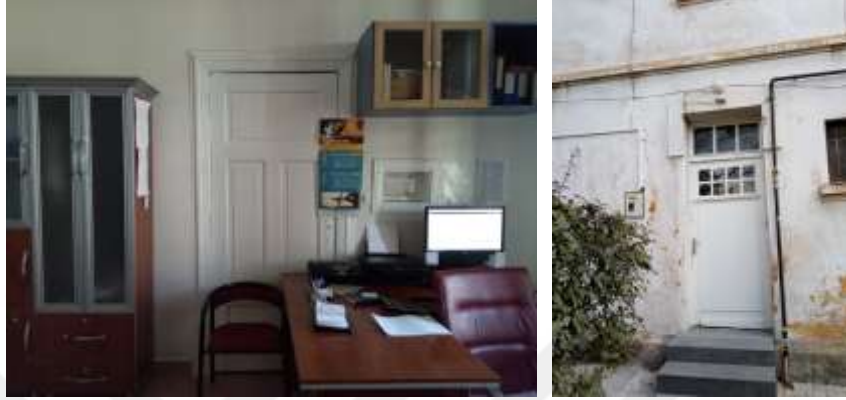
Şekil 5.46. İşlevsizleştirilen ahşap kapı ve dış kapılardan biri (Özmertyurt 10.05.2018).
