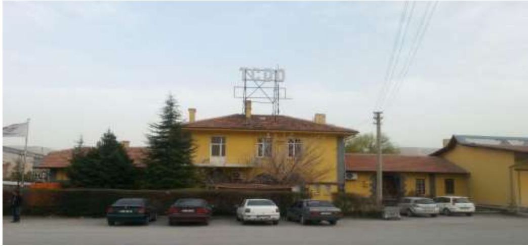
Şekil 5.23. Ana Gar Binası kuzeybatı cephesi(Özmertyurt, 20.05.2018)
