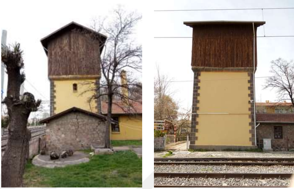
Şekil 5.60. Kuzeydoğu ve güneydoğu cepheleri (Özmertyurt 10.05.2018).
