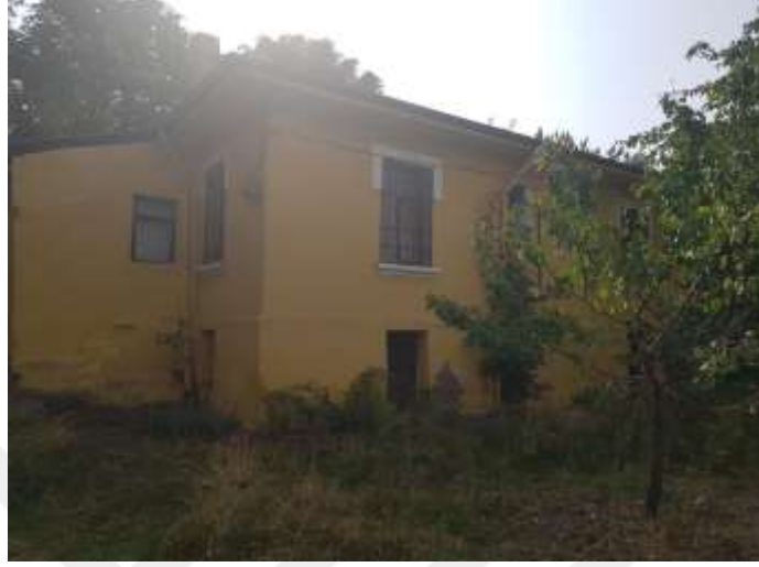
Şekil 5.72. 9 Nolu Gar Lojman binası kuzeybatı cephesi (Özmertyurt, 16.10.2018)
