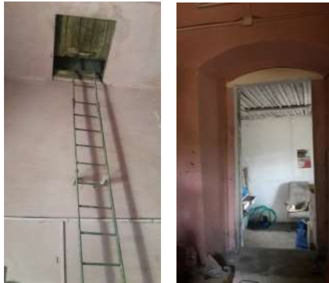
Şekil 5.55. Su Kulesine çıkan merdiven ve diğer odaya geçişte basık kemerli kapı (Özmertyurt 10.05.2018).
