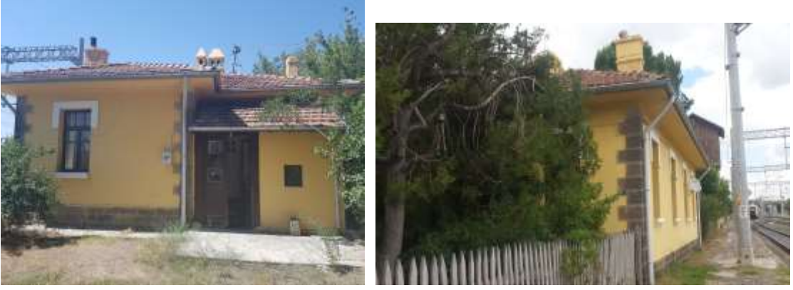
Şekil 5.34. Gar Lojman Binası 1, solda kuzeydoğu ve sağda güney cephesi (Özmertyurt, 18.07.2018).
