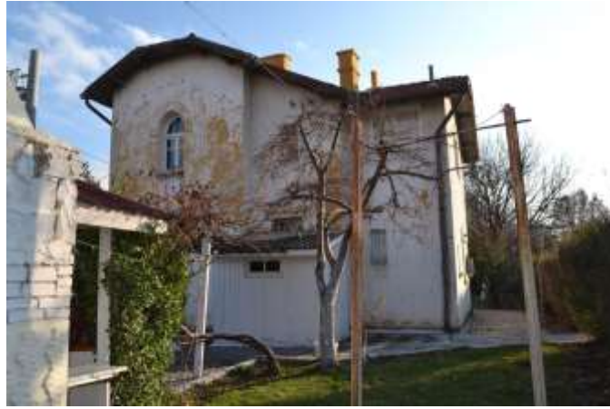
Şekil 5.41. Gar Lojman Binası 2 kuzeydoğu cephesi (Özmertyurt, 18.07.2018).
