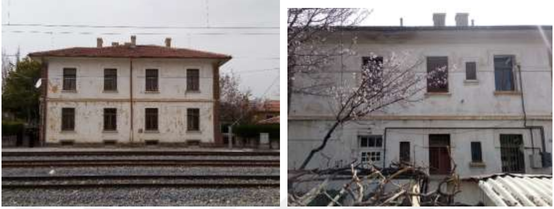
Şekil 5.44. Gar Hizmet Binası 2, solda güneydoğu cephesi ve sağda kuzeybatı cephesi.
