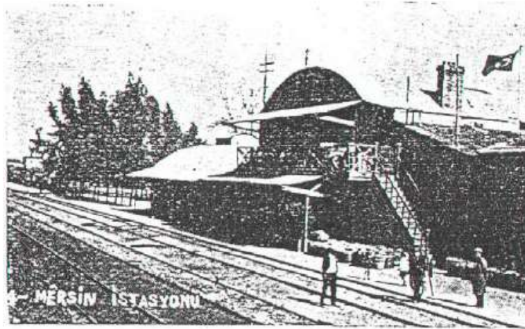
Şekil 3.19. Mersin Tren İstasyonu (Çoygun, 1996)
