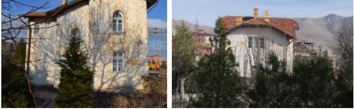
Şekil 5.42. Gar Lojman Binası 2 solda güneybatı ve sağda kuzeybatı cephesi (Özmertyurt, 18.07.2018).
