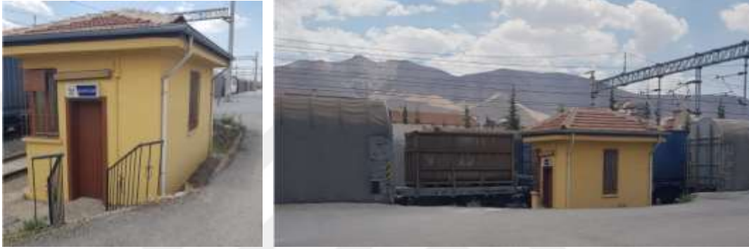
Şekil 5.76. Kantar binası (Özmertyurt, 05.04.2018)
