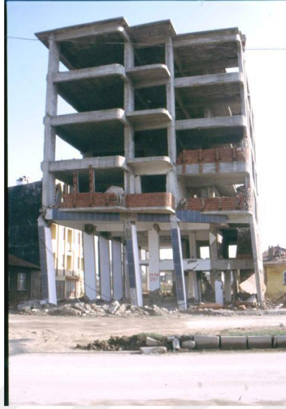
Şekil 4.19. İzmit yumuşak kat örneği (Özgen, 2002)
