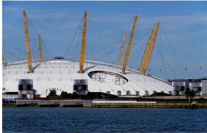
Şekil 4.54. Milenyum Kubbesi, İngiltere Asma germe kablolu strüktüre sahip bu yapı 225 metre açıklığı geçmektedir. Bu açıklığı geçen strüktür çözümü yapının biçimini belirlemektedir ve estetik yapısının bir parçasıdır (Macdonald, 2018)
