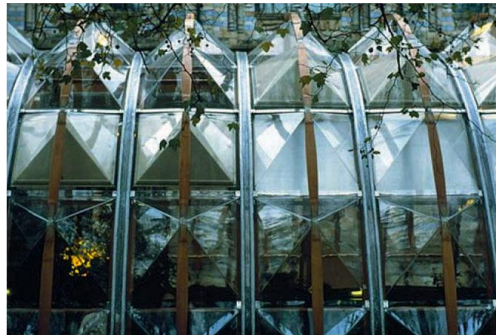
Şekil 4.56. IBM Avrupa gezici pavyonu, geliştirilmiş membran sistemi lamine kereste ve plastik kombinasyonu ile elde edilmiş (Macdonald, 2018)
