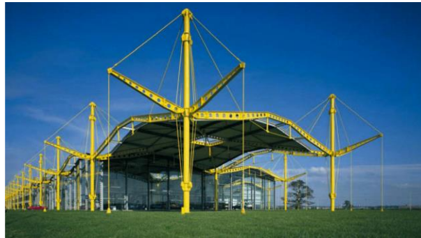
Şekil 4.52. Renault Satış Merkezi, İngiltere, Mimar Norman Foster ve Strüktür Mühendisleri Ove Arup ve ortakları, (Macdonald, 2018)
