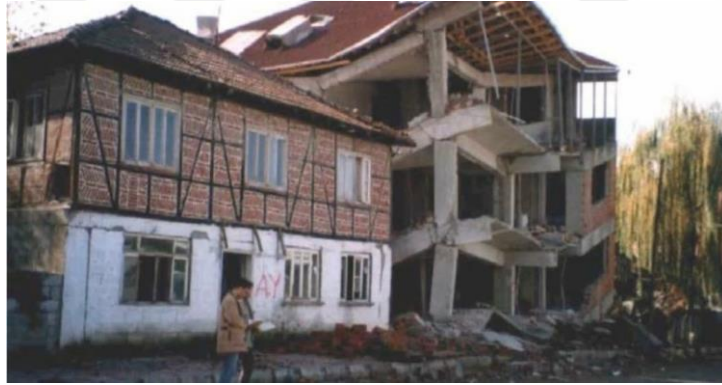
Şekil 5.11. Keşmir Bölgesinde bulunan geleneksel ahşap çerçeve yapı (ülkemizde de aynı teknikle üretilmiş birçok yapı vardır) ve betonarme yapının 2005 depreminde hasar durumu (Sofi ve ark., 2017)
