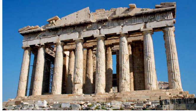
Şekil 4.25. Parthenon Atina, düz atkılı sistem (Macdonald, 2018)
