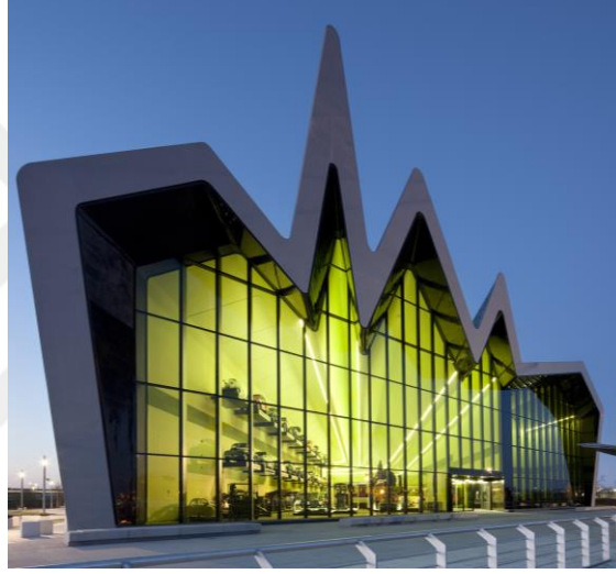
Şekil 4.58. Riverside Müzesi, tasarım karmaşıklığı ve strüktürel yaratıcılık malzeme özgünlüğü ile birleşmiştir. Düzensiz tırtıklı çatı formu çelik çerçevelerden oluşmuştur ve kaplanmıştır (Anonymous, 2012)
