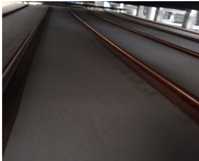
Şekil 3.12 PVT-su kolektördeki borulama sistemi
